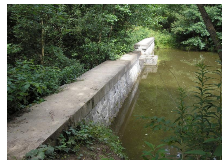
1-1-6 MVN-obnažené výpustné zařízení
