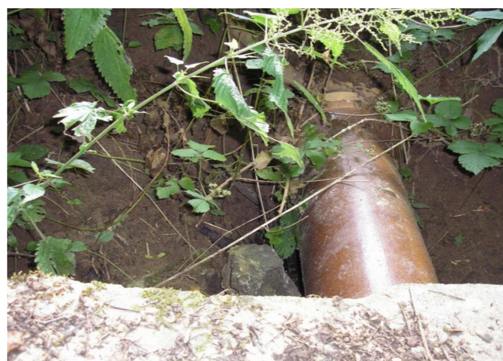
1-1-5 MVN-obnažené výpustné zařízení
