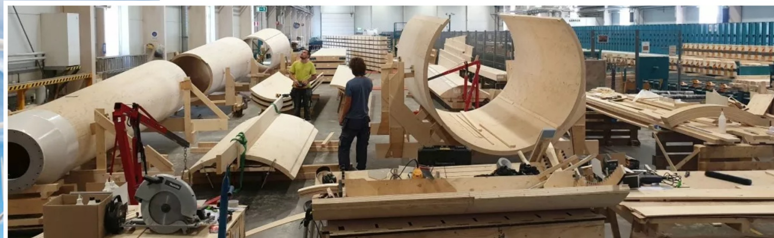
Bau eines Holzwindrads in Schweden: Analysten bescheinigen dem Material viel Potenzial.
